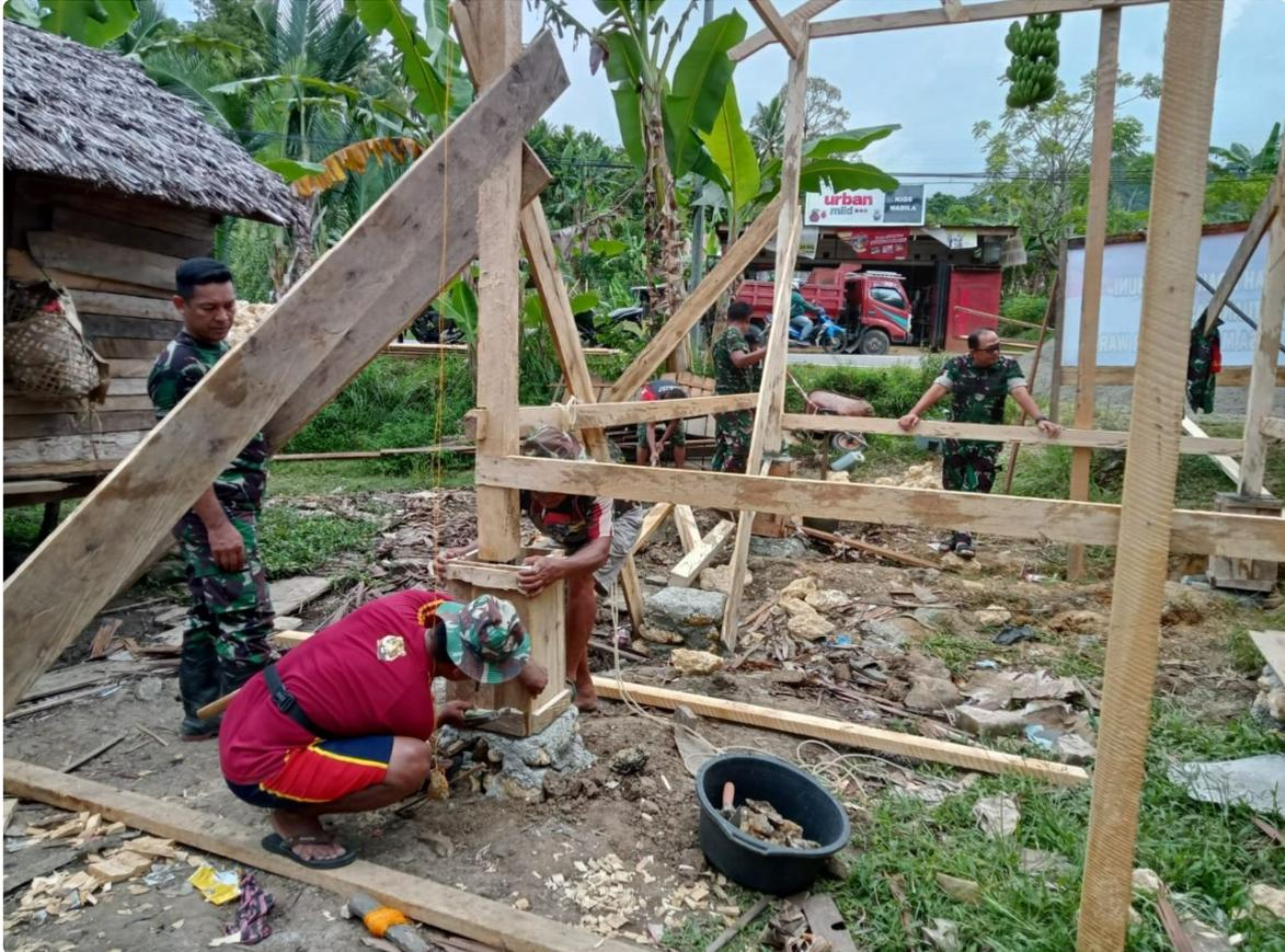
Sasaran Pokok Progres Kali ini termasuk Pembongkaran Rumah, Pembersihan Lahan, Pengukuran dan pemasangan patok tiang serta pemotongan besi sudah memasuki tahap 100 persen. Termasuk Penggalian Lubang tiang dan pengecoran tiang rumah 75%, Pembuatan rangka rumah 50 %, lalu Mendirikan Rangka Rumah 50%
